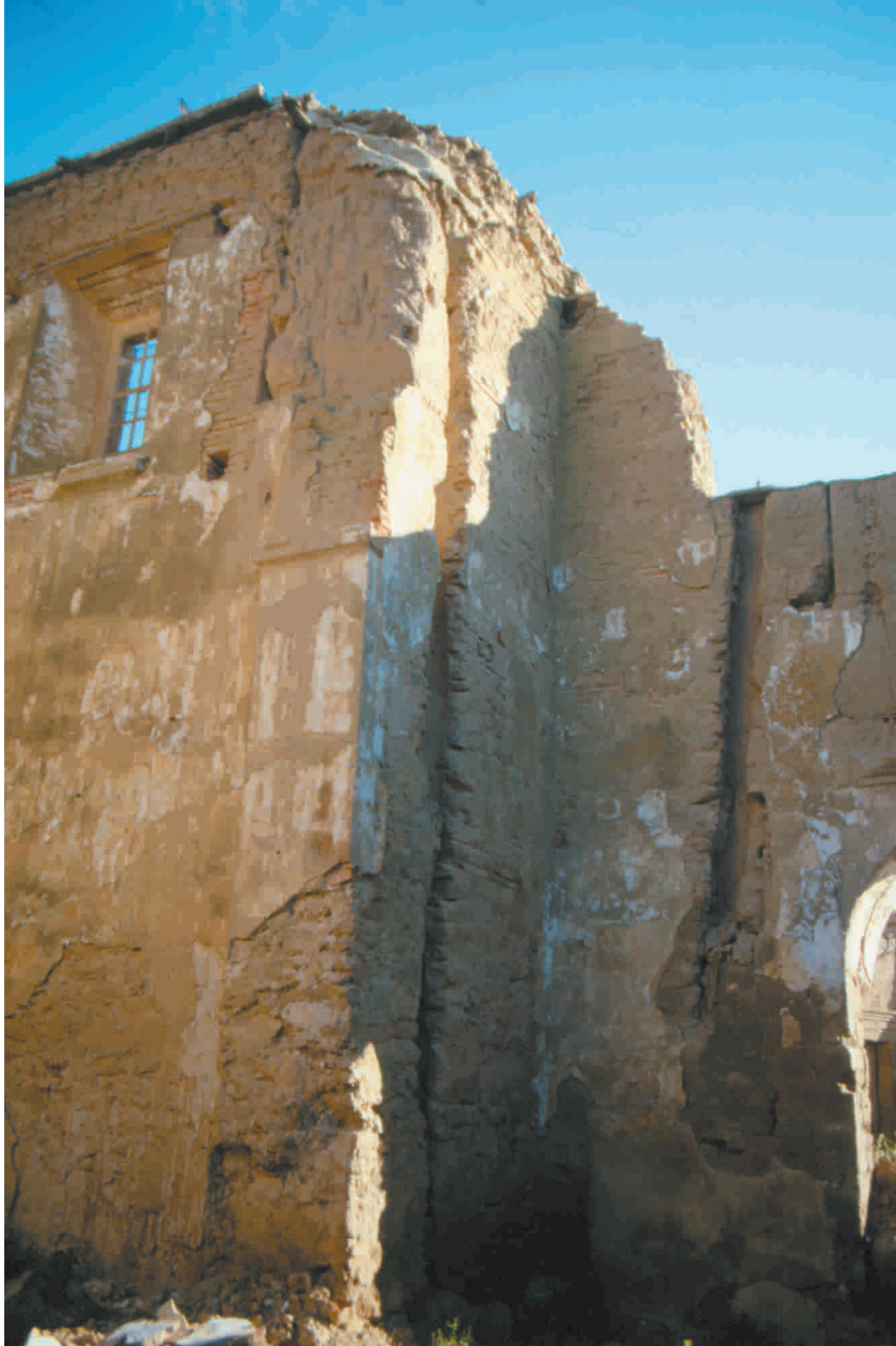
A partir de un zócalo de piedra de sillería, el templo nos muestra una fábrica de tierra, sobre todo, en la que las tapias y el adobe se mezclan alternando con ladrillo en pilares, ángulos y esquinas.
