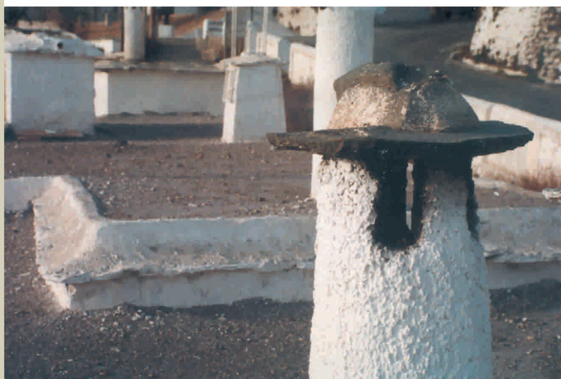
Chimenea en Capileira
