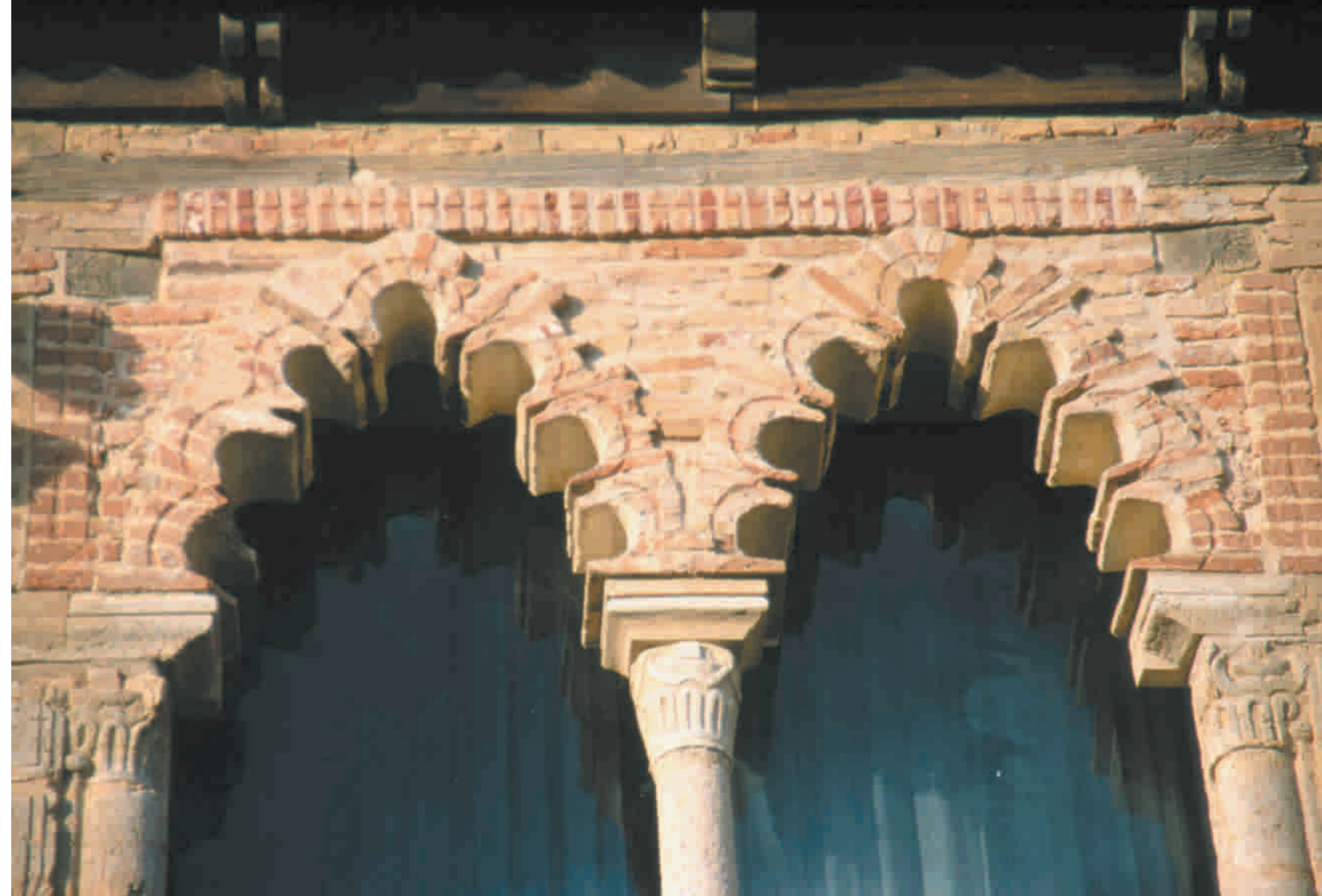
Ventana ajimezada sobre la entrada principal. Los arcos lobulados realizados con diferentes piezas cerámicas descansan en las tres columnillas de piedra rematadas en sencillos capiteles.
