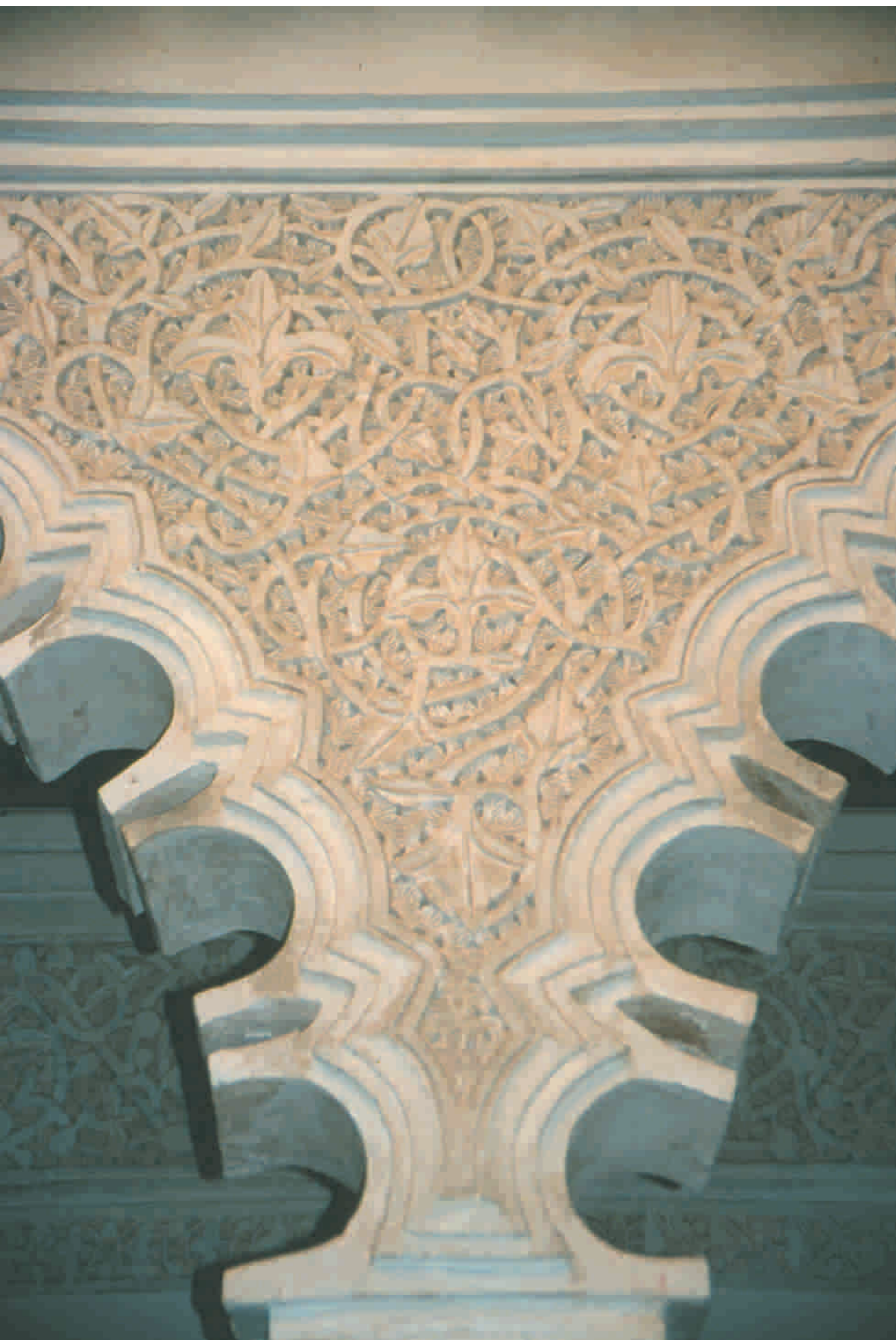
Labores de yesería del patio árabe mostrando labores de ataurique entre los dos arcos que forman cada lado.
