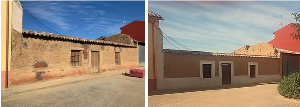
La fachada del terreno donde transcurrieron el curso y el examen ECVET, al inicio de la intervención y ya terminada
