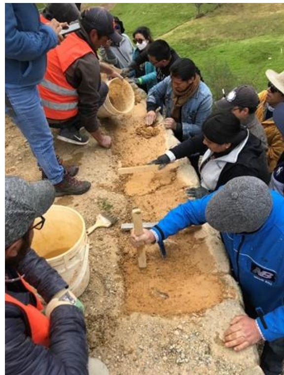
Consolidación de un muro bajo del monumento durante los talleres de capacitación para la comunidad (Foto: L. Guerrero, 2022)
