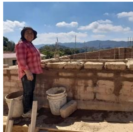
Las primeras hiladas de la obra
