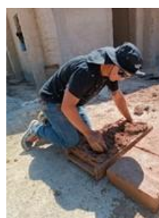
Santiago preparando y desmoldando adobes en pares
