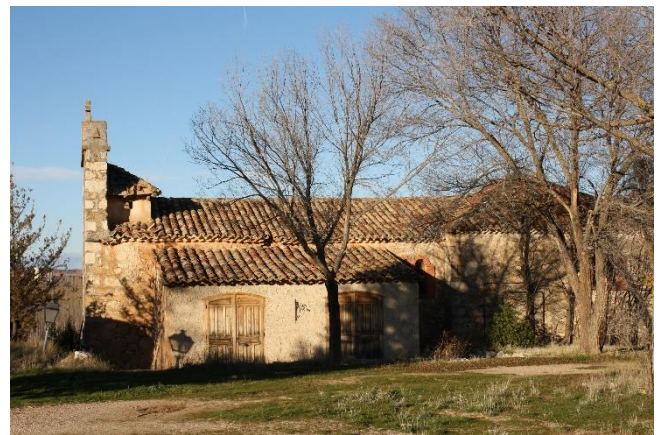
Iglesia-aula y sala de exposiciones
