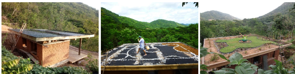
Figura 23 – Execução do telhado jardim da edícula do Sítio São Pedro, Ceará (Autor: Márcio Holanda)
