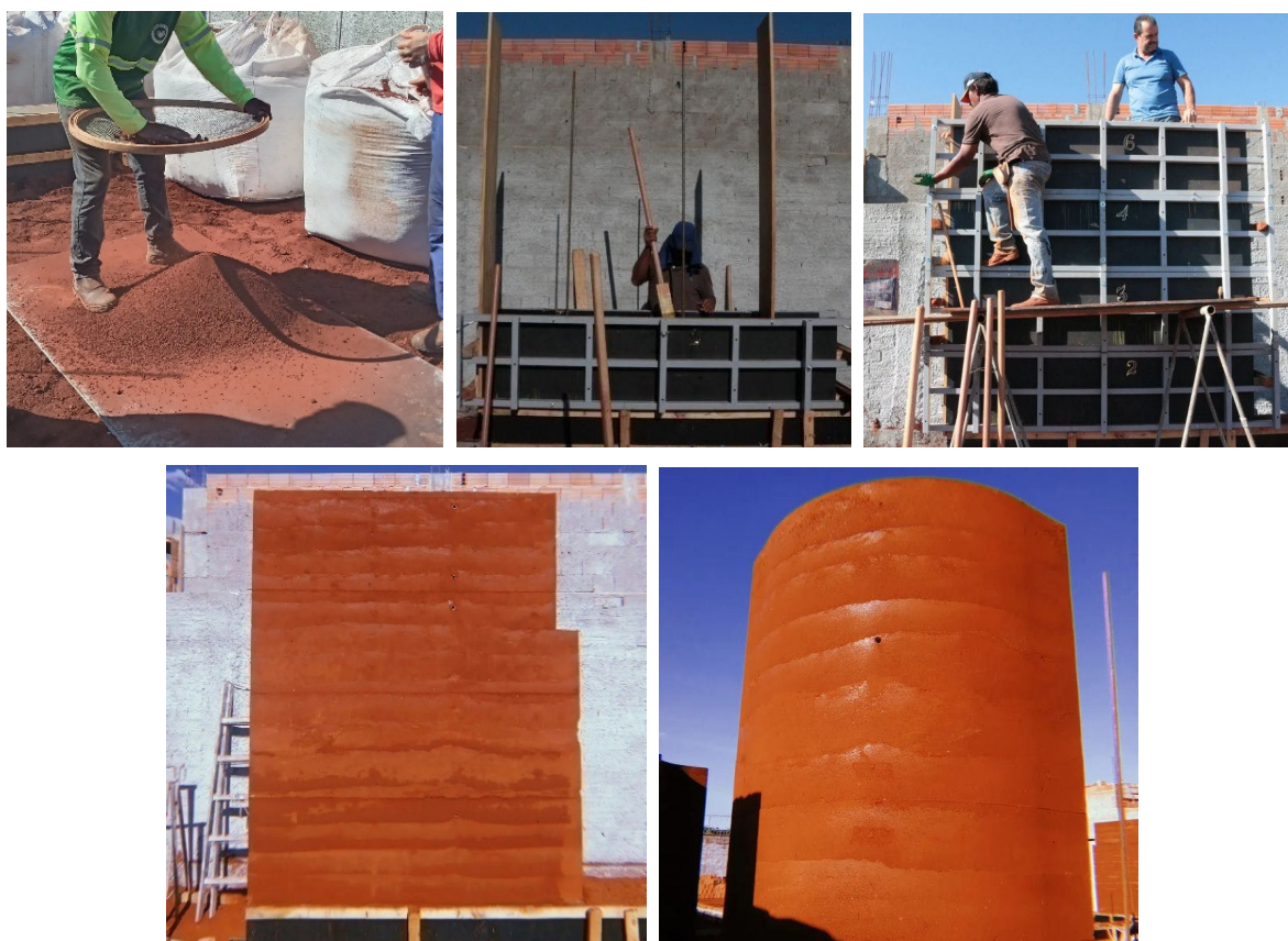
Figura 21 – Peneiramento de terra, apiloamento manual, fechamento da fôrma e paredes simples e curva com taipa de pilão da residência J e K, São Paulo (Autores: Matheus Petian Lima, Eduardo Salmar, João Marcuz)
