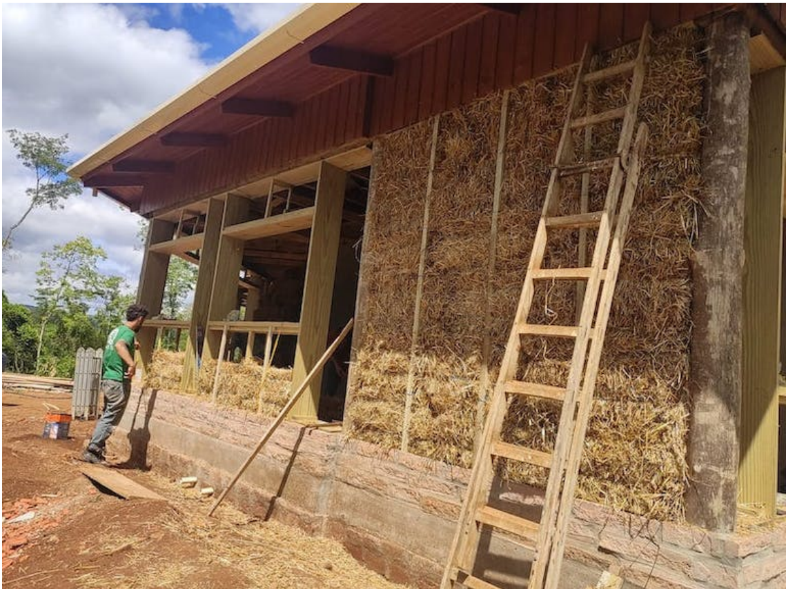
Figura11 – Casinha da Palha e suas paredes com fardos de palha, Rio Grande do Sul (Autora: Vika Martins)
