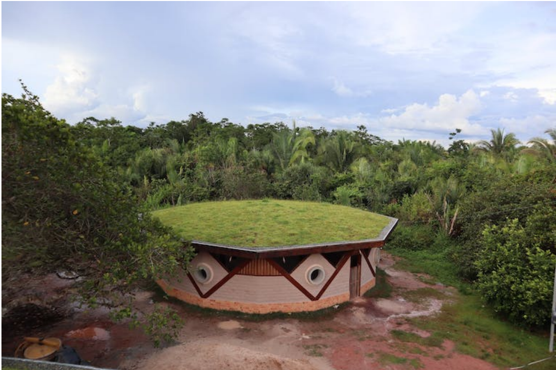
Figura 22 – Telhado jardim no Redário, Maranhão (Acervo TIBÁ Arquitetos)
