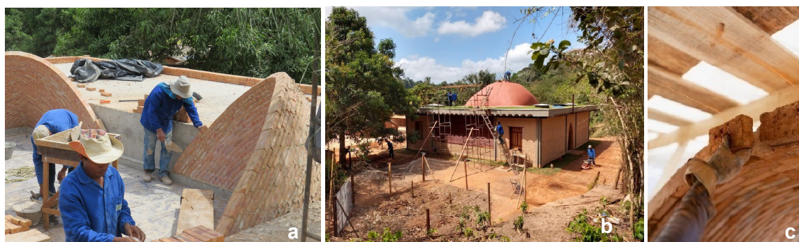
Figura2 – a e b – Execução Casa de Conversa, Maranhão (Acervo Tibá Arquitetos); c – Execução da Casateliê, Bahia (Autora: Rafaella Azevedo)
