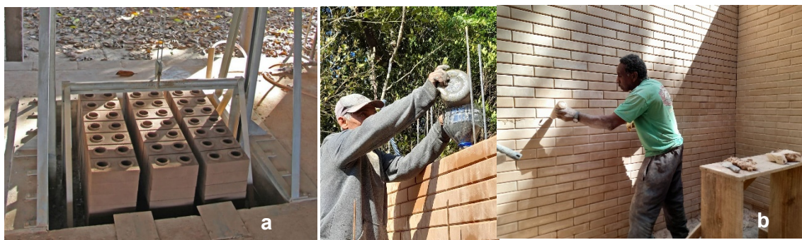
Figura6 – a)BTC (AcervoEcoterm.org); b) Enchimento e rejunte de parede com BTC da Casa Verdes Colinas, Santa Catarina (Autor: Marcos Marques)
