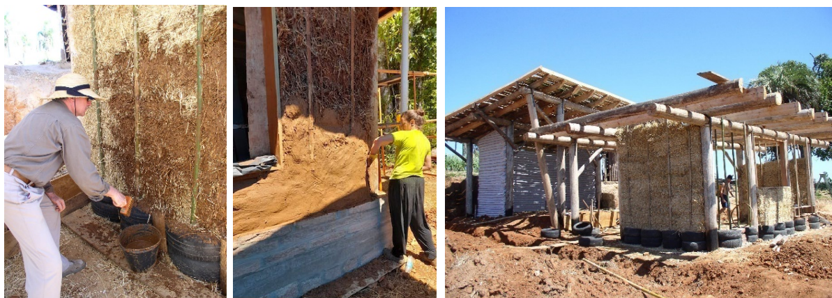
Figuras12 – Gernot Minke aplicando reboco na parede de fardo de palha da Oficina Filhos de Sapé, Rio Grande do Sul (Autora: Vika Martins)
