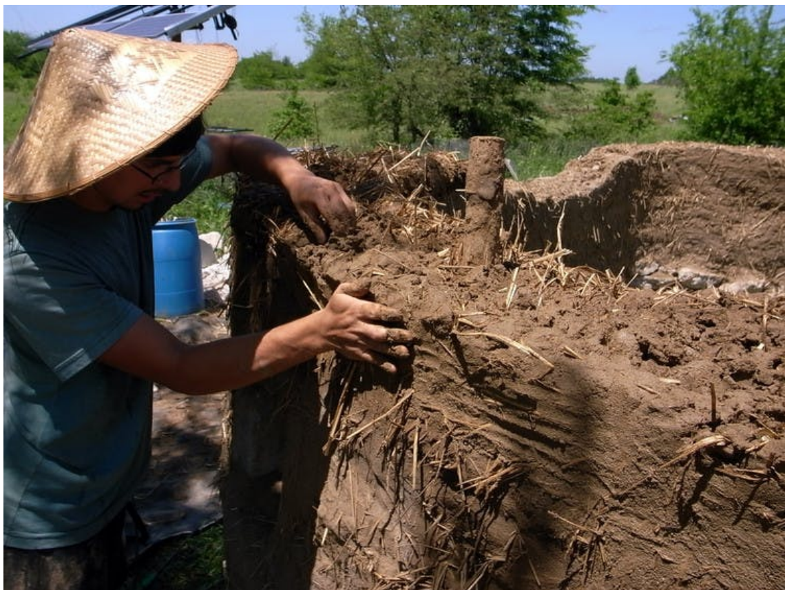
Figura7 – Execução de parede com cob (Fonte: Archdaily)
