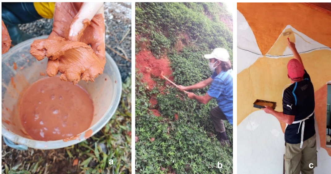
Figura 17 – a) Preparo da tinta de terra da Parede Mandala, Santa Catarina (Acervo Arterativamente); b) Coleta de solo e pintura com tinta de terra do projeto Cores e Montanhas do Caparaó, Minas Gerais. (Autora: Marcela da Terra)
