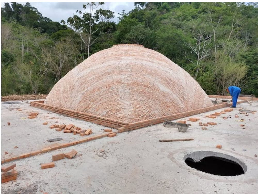
Figura 1 – Execução de abóboda na Casa de Conversa, Maranhão (Acervo Tibá Arquitetos)
