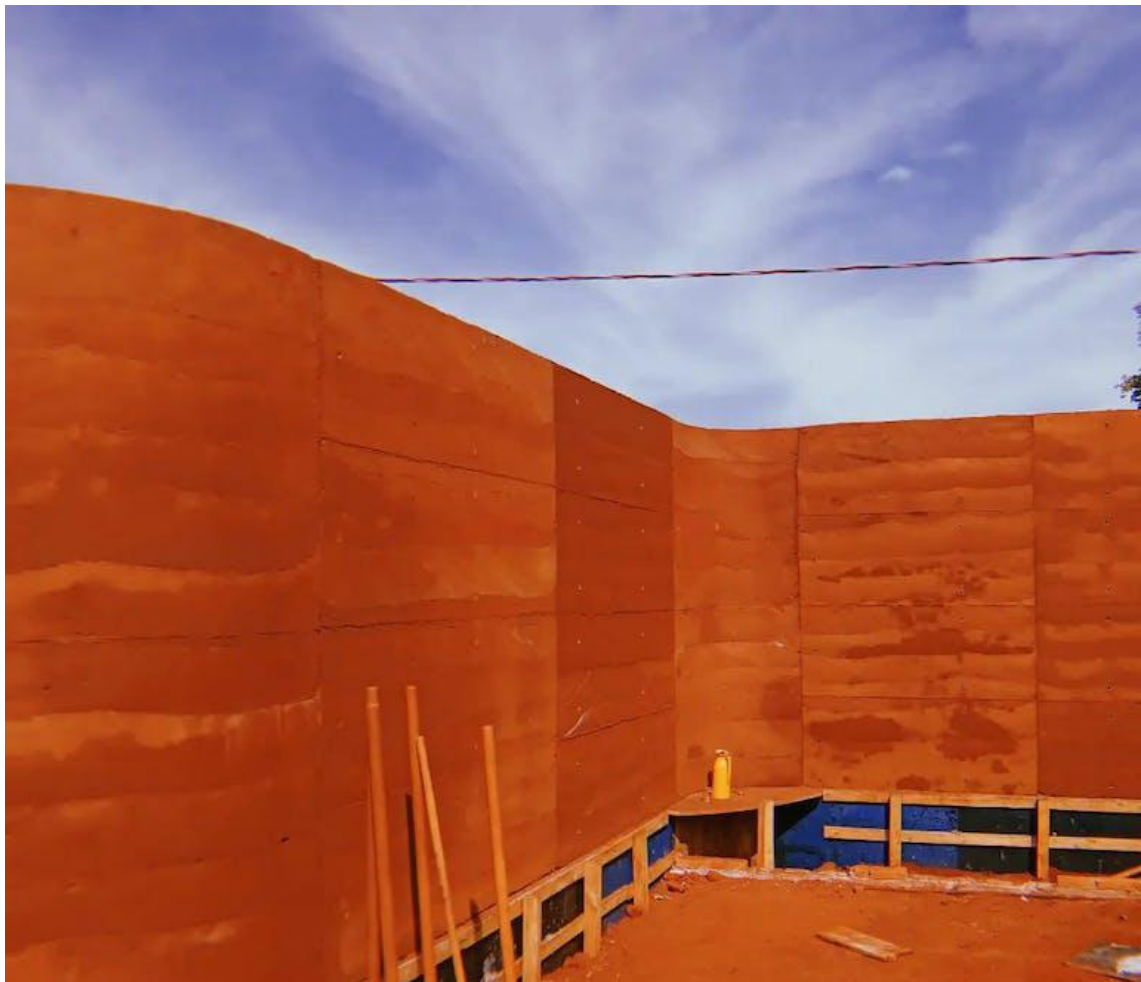
Figura 20 – Parede de taipa de pilão da residência J e K, São Paulo (Autor: Matheus Petian Lima)
