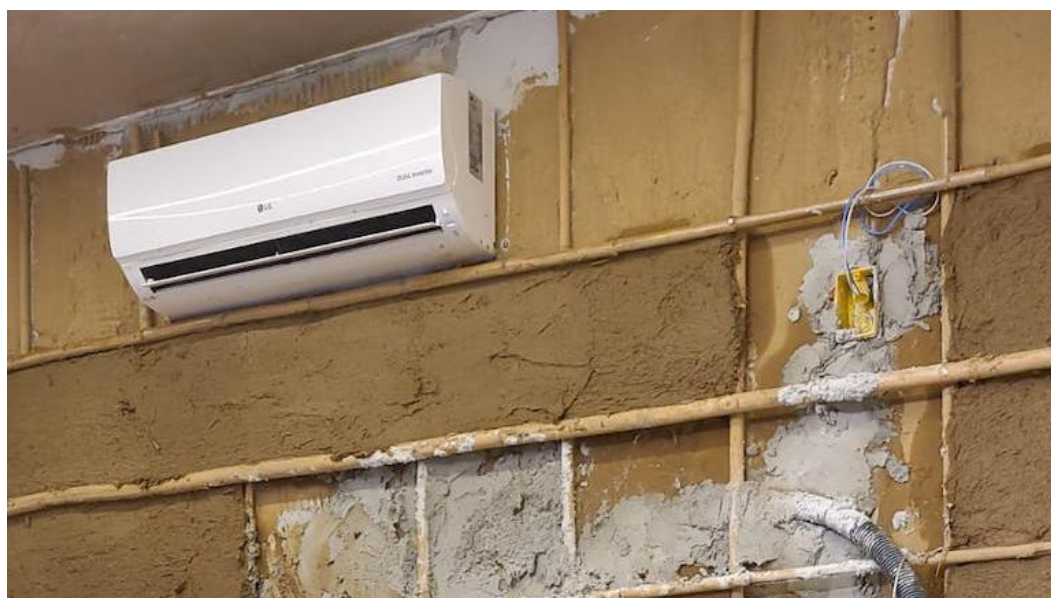
Figura18 – Aplicação de revestimento de terra, Rio de Janeiro (Autora: Camila Llerena Hue)
