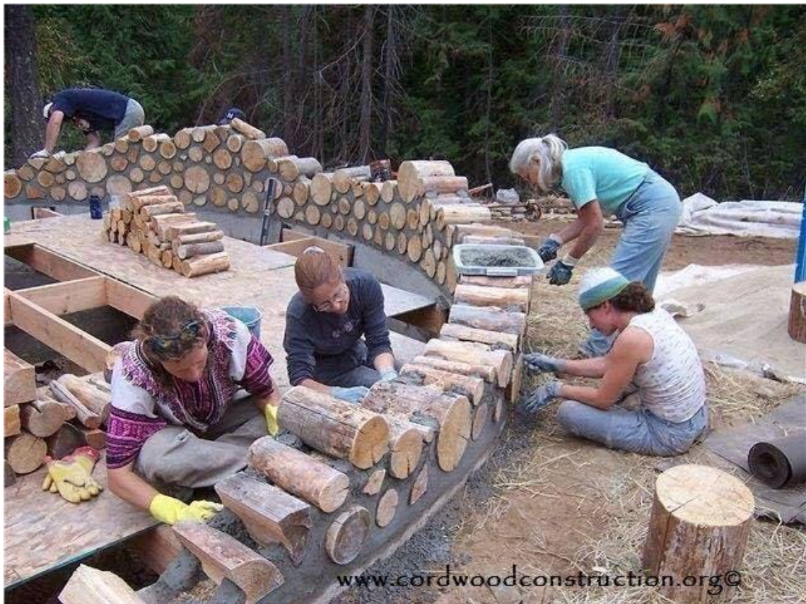
Figura9 – Execução de parede com cordwood (Fonte: https://cordwoodconstruction.org/ )
