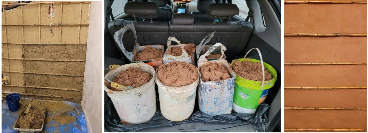
Figura 19 – Aplicação de revestimento de terra, massa e parede pronta, Rio de Janeiro (Autora: Camila LlerenaHue)
