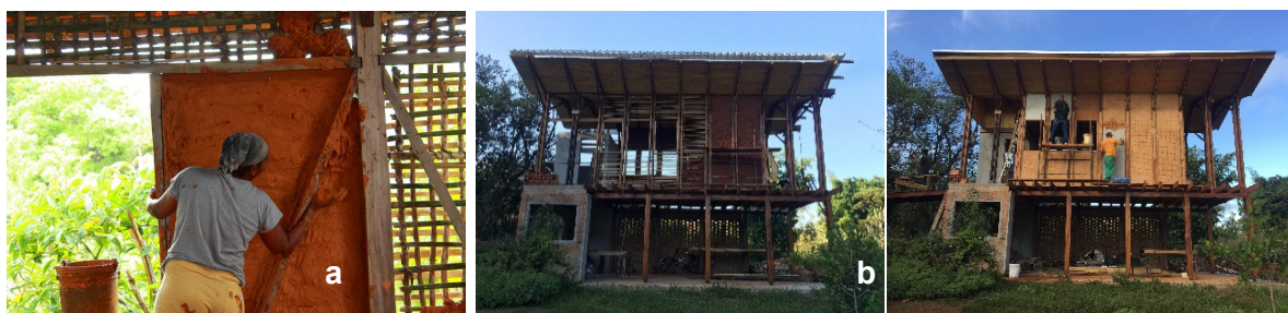
Figura 15 – a) Barreamento da cozinha tradicional quilombo Ivaporunduva, São Paulo (Autor: Alain Briatte Mantchev); b) Barreamento e reboco do Chalé Demétria, São Paulo (Autora: Mariana Cintra)
