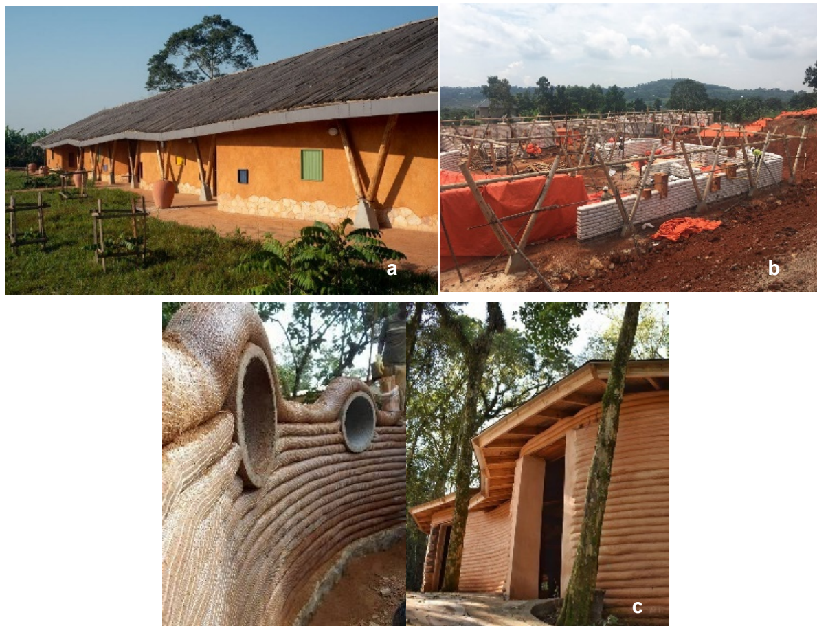
Figura 25 – a) Escola Mustardseed construída com terra ensacada, Uganda (Acervo Will Boase Photography); b) Terra ensacada na Casa Viva, Minas Gerais (Acervo Biohabitate); c) Cidade Escola Ayni com paredes de terra ensacada, Rio Grande do Sul (Acervo Biohabitate)
