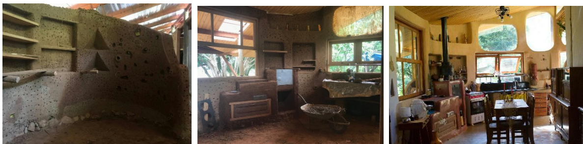
Figura8 – Execução de paredes de cob na Casa de Terra, São Paulo (Autor: TathyYazigi)
