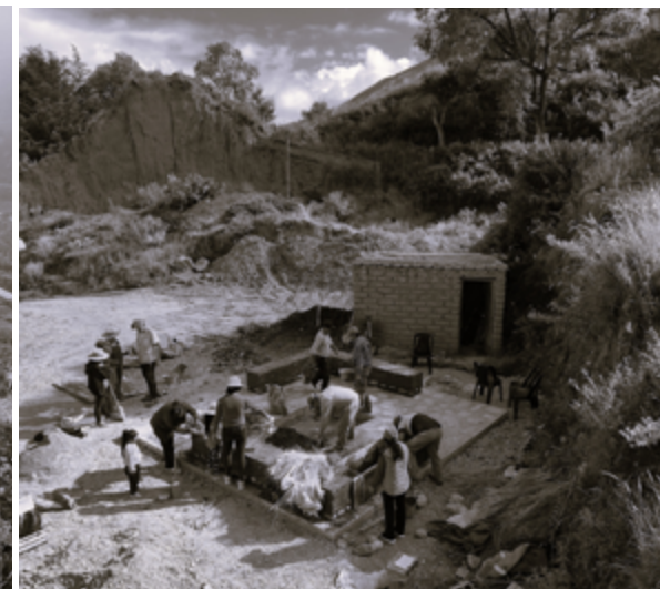
Momento del taller en el se puede observar la construcción de bancos de tapiales. Créditos: de la autora.
