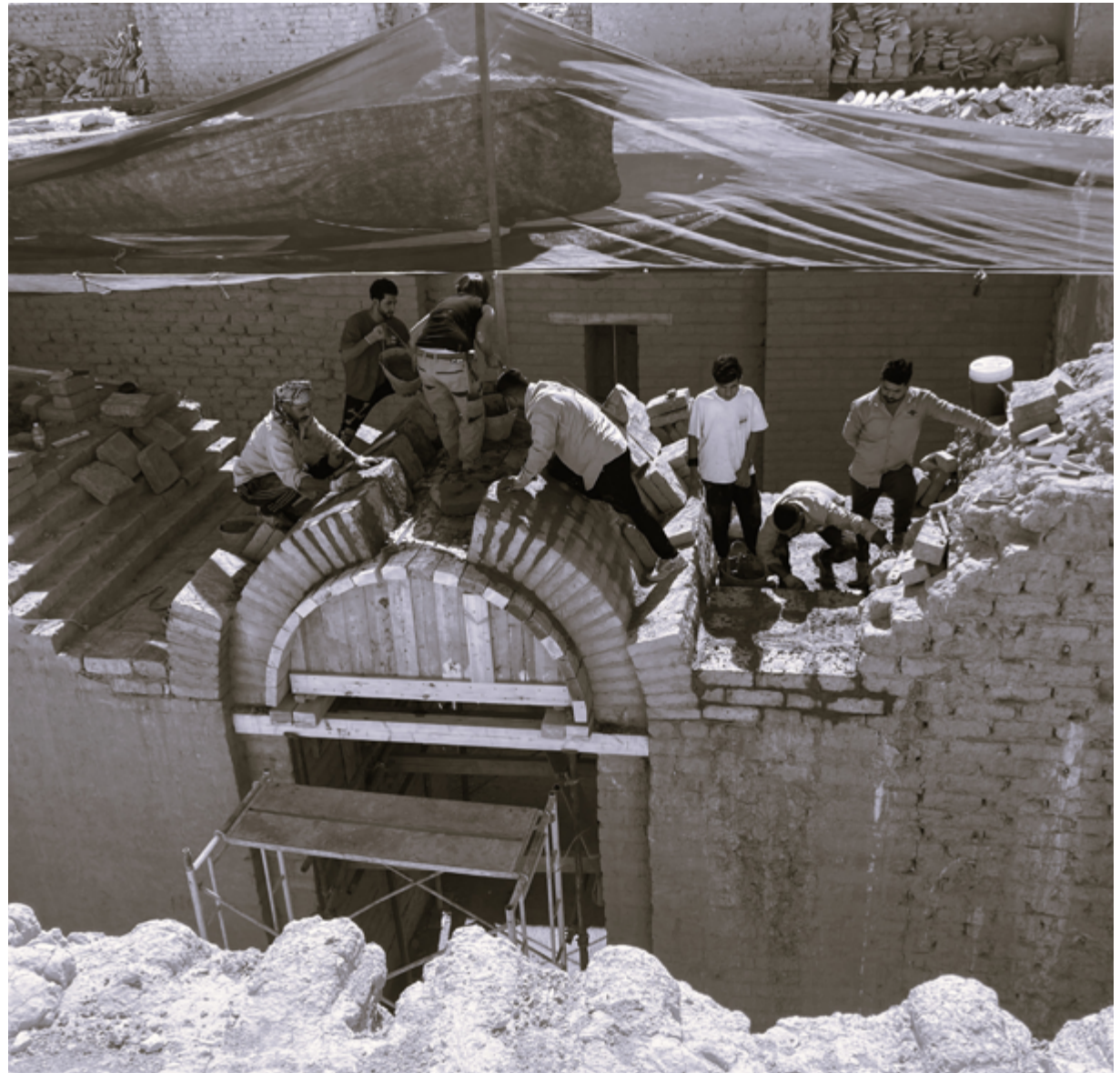
Ejecución de arco de adobes dirigido por la arquitecta Lara Davis, con el equipo de Albañiles de la obra de reconstrucción del Templo de Ninmakh por World Monuments Fund (Babilonia, Irak). Créditos: Amanda Rivera Vidal.
