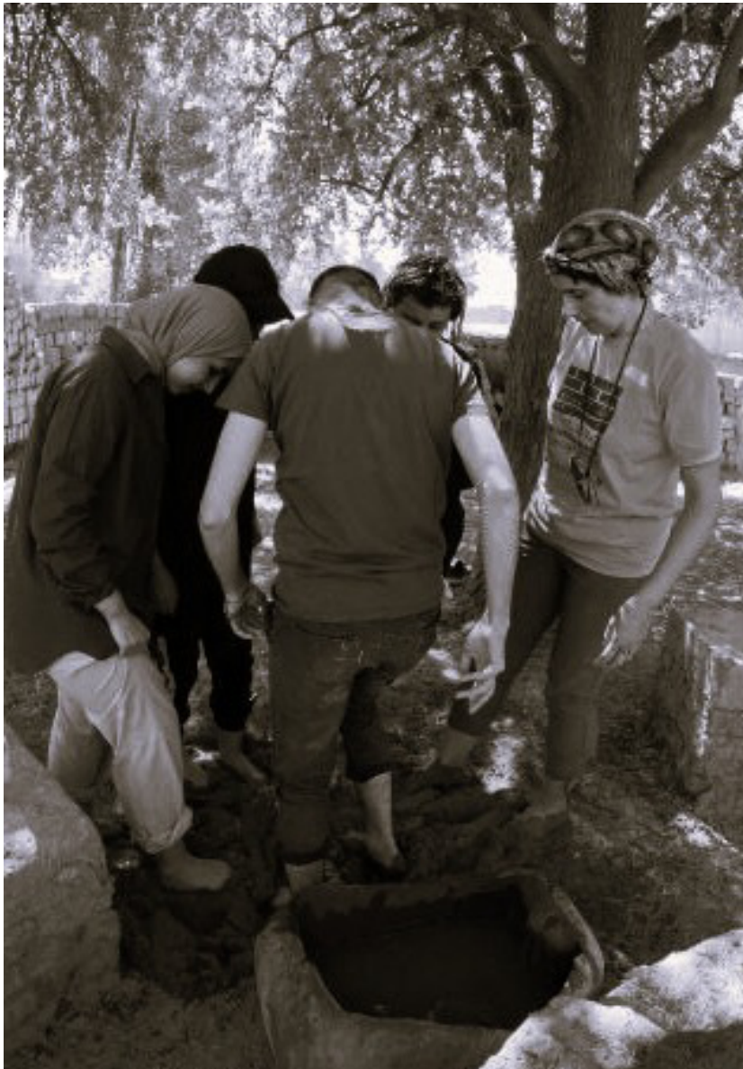
Realización de mezcla de tierra y fibra para los adobes con Amanda Rivera Vidal. Créditos: Ammar Altaee.
