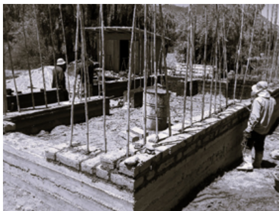
Elevación de muros de adobe con el refuerzo de cañas recomendado por la Norma Técnica E.080 del Perú. Crédito: LAAyCT
