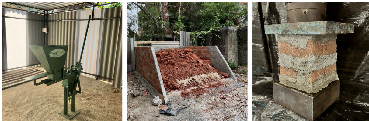
Etapas preliminares: Aquisição da prensa e construção do galpão; Construção da baías e aquisição da terra; Ensaio de compressão. Fotografia: Rafael Fogel
