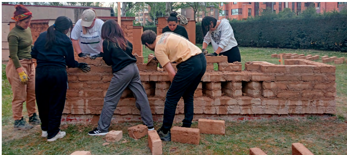
Trabajos de construcción del muro por parte de los alumnos. Fotografía: Félix Jové
