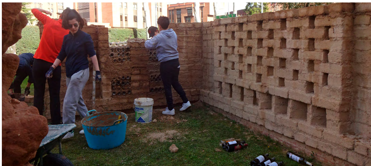
El muro prácticamente terminado en los jardines de la Escuela de Arquitectura. Fotografía: Félix Jové
